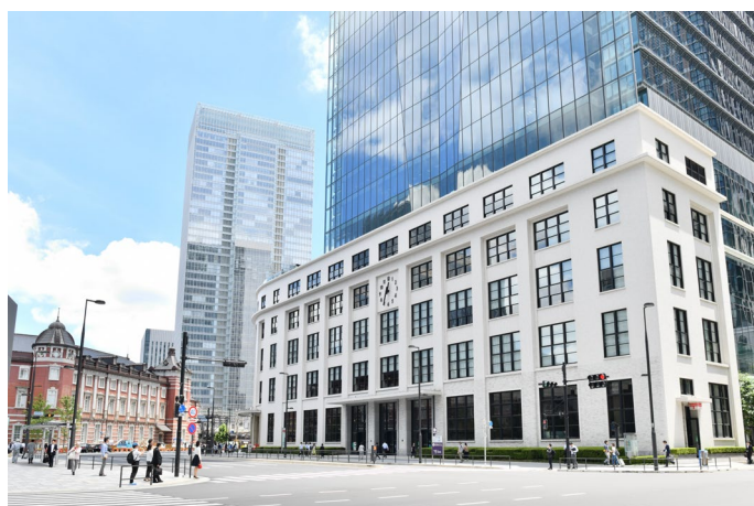
東京中央郵便局が入る「JPタワー」低層部
